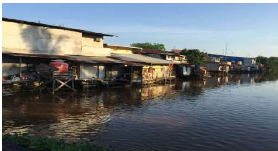
(Gambar 4.6 Kondisi Bantaran Sungai)
