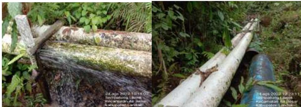
*Gambar 2.13 kebocoran pipa paralon.*
